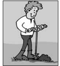
1. Hjørnepælene af trykimprægneret norsk fyr bores eller nedrammes minimum 120 cm i jorden.
