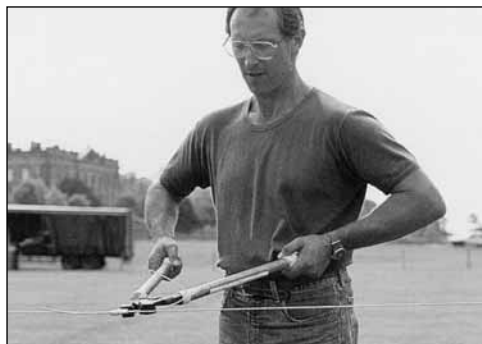
Opstramning med Gripple værktøj (16611).
