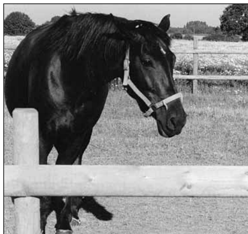
Lægtehegn af norsk fyr. Bemærk at lægterne er affaset af sikkerhedshensyn, så man undgår splinter.
